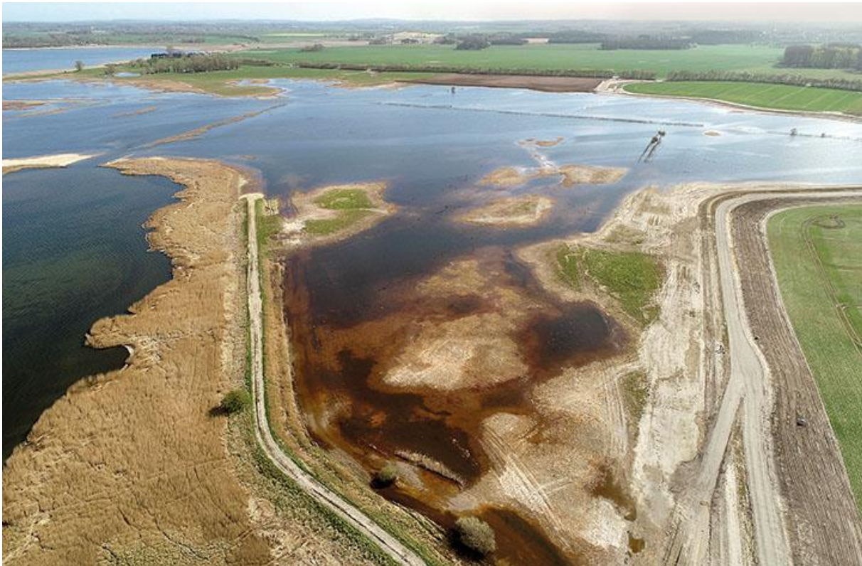
Abb. 1: Luftaufnahme des Polders Drammendorf am 17.4.2020 nach der Renaturierung. Der alte Deich ist bis auf einen kurzen Rest verschwunden, der neue Riegeldeich (rechts im Bild) schützt die Ackerflächen östlich des Deichs (Foto: WWF)
