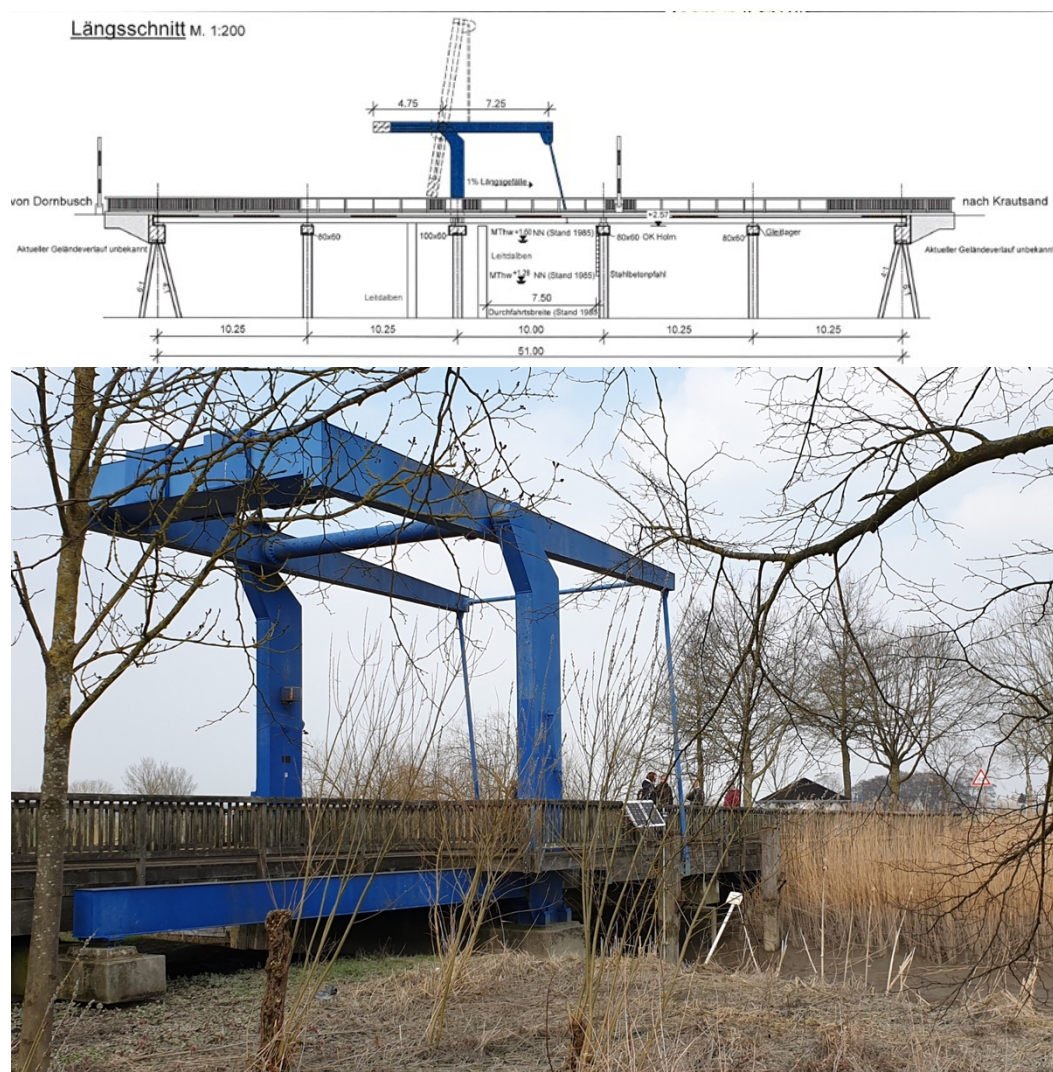
Abbildung 3.8: Klappbrücke bei Dornbusch im Querschnitt (oben, [Quelle: Gemeinde Drochtersen]) und vor Ort (unten, [Quelle: DHI WASY])
